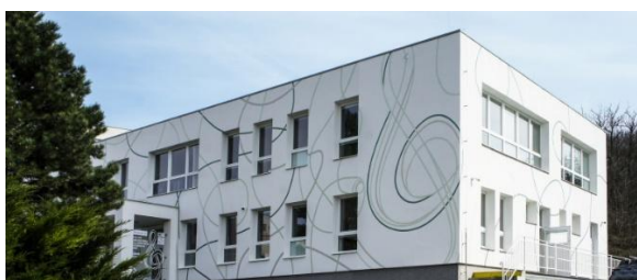
Hlavní budova ZUŠ Došlíkova 4185/48 v Brně-Židenicích.
